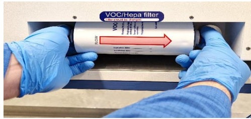
Abbildung 12.2 Verfahren zum Einsetzen und Entfernen des LCKW/HEPA-Filters
